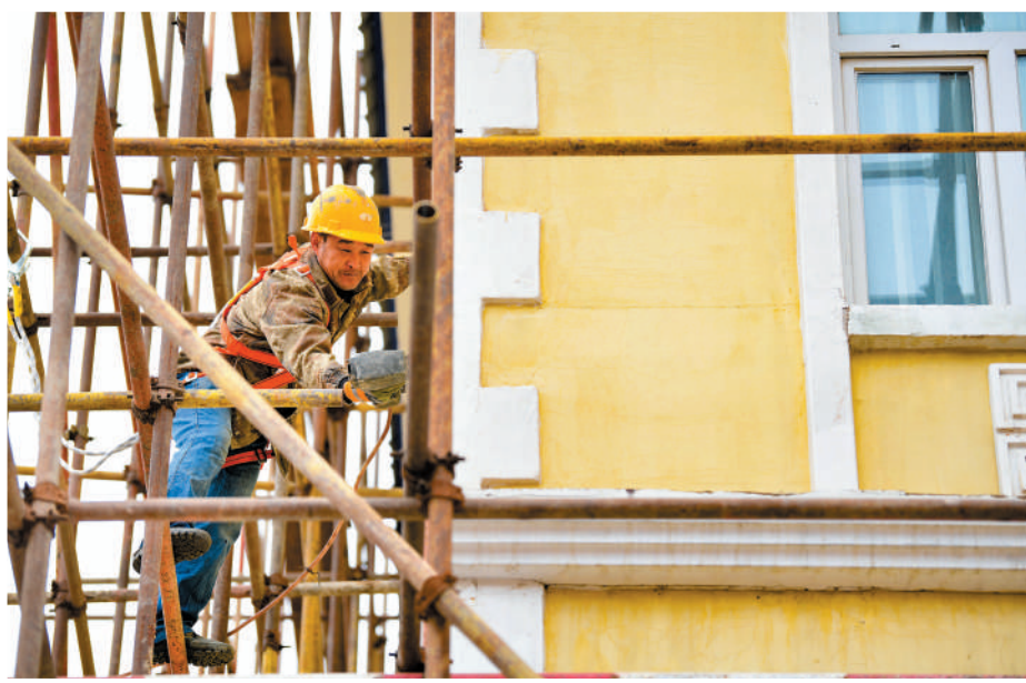
内蒙古自治区兴安盟阿尔山市温泉街神泉社区老旧小区改造项目施工现场。王正摄(人民视觉)
