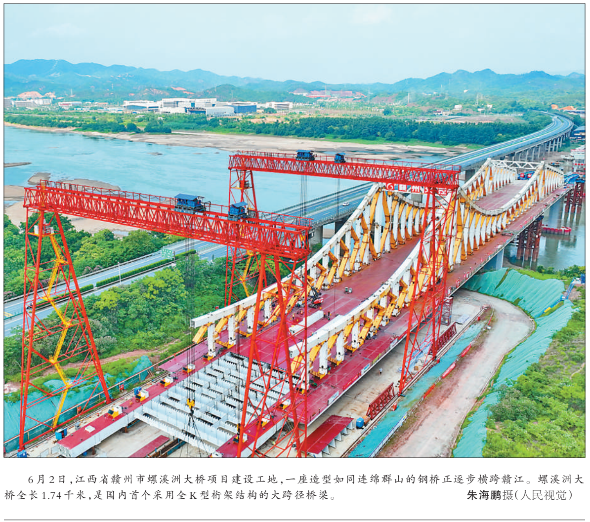
6月2日，江西省赣州市螺溪洲大桥项目建设工地，一座造型如同连绵群山的钢桥正逐步横跨江。螺溪洲大桥全长1.74千米，是国内首个采用全K型桁架结构的大跨径桥梁。朱海鹏摄(人民视觉)
