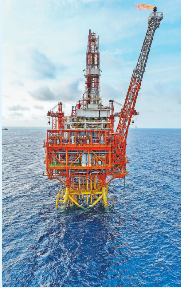
右图：6月1日拍摄的恩平15-1原油钻采平台。新华社记者 毛思倩摄
