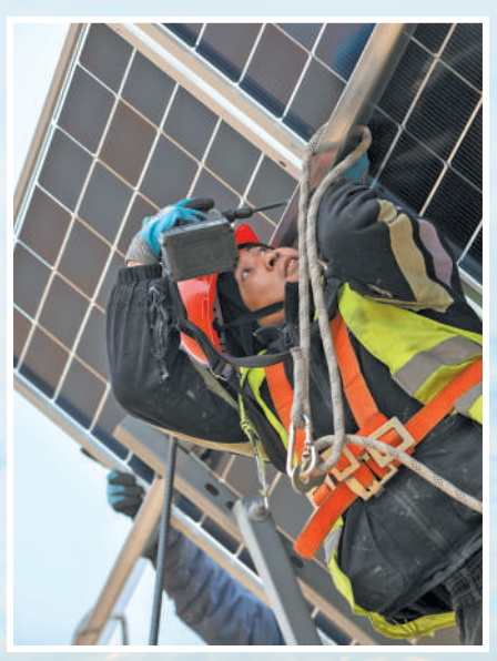
工作人员在安装光伏板。丁根厚摄
