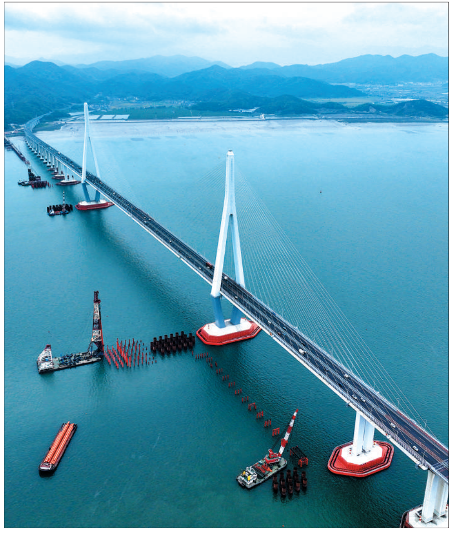
浙江省宁波至象山市场(郊)铁路工程象山港跨海大桥建设现场，工人们正抢抓工期，全力奋战。
