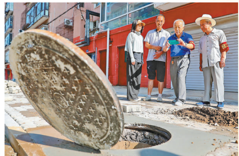
河北省秦皇岛市海港区建兴里社区内，由老党员、退休干部组成的社区老旧小区工程质量监督队成员在拍摄污水管线铺设情况。 曹建雄摄(人民视觉)
