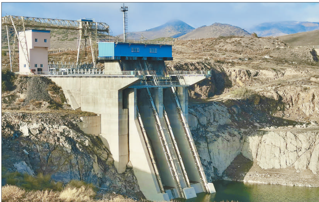
由中国水利电力对外公司承建的玛依纳水电站，位于哈萨克斯坦东南部的恰伦河上，自投入运营以来，年发电量约10.27亿千瓦时，极大缓解了哈南部地区电力紧张状况。 张国平摄
