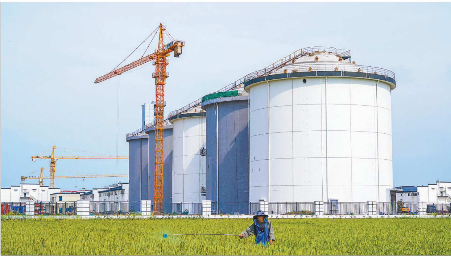
二十万余吨。图为五月六日，粮食产业园建设现场。十七栋低温平房仓、十栋低温浅圆仓、粮食加工厂房和烘干中心，建成后，仓容量可达江苏省宿迁市宿豫区粮食产业园项目集仓储物流、加工贸易等为一体，规划建设
