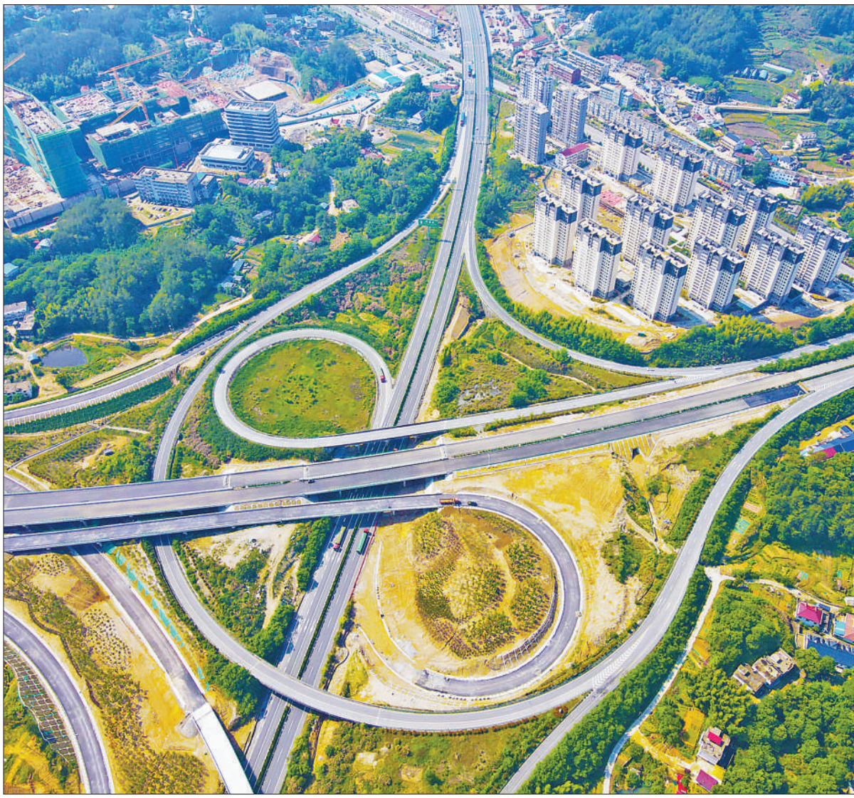
5月7日,安徽省安庆市岳西县莲云乡平岗村,高速公路交叉纵横。近年来,当地持续加大基础设施建设力度,补齐硬件短板,群众获得感、幸福感不断提升。吴均奇摄(影像中国)
