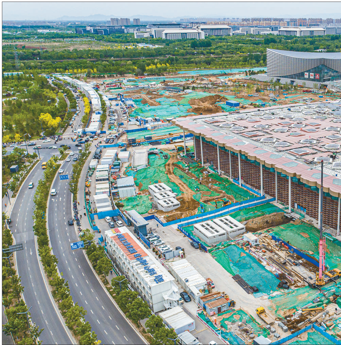
北京城市副中心图书馆项目位于北京市通州区城市绿心森林公园西北部市民文化休闲组团,是城市副中心“一带、一轴、两环、一心”规划格局的重要组成部分。目前,该工程正处于装饰装修阶段,建设者正向着建成交付的节点目标任务全力冲刺。图为建设中的北京城市副中心图书馆项目。本报记者 张武军摄
