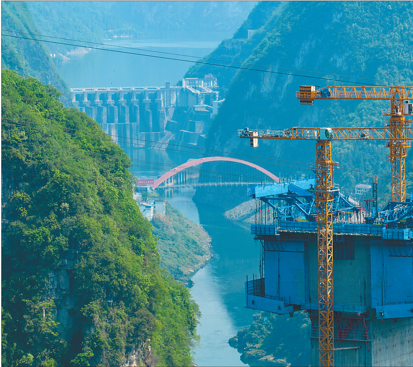
渝湘复线高速公路磨寨乌江特大桥位于重庆市彭水苗族土家族自治县，是一座矮塔斜拉索大桥。项目建成通车后，将缓解渝湘高速的通行压力，进一步便捷沿线区县的交通运输、促进经济社会发展。
