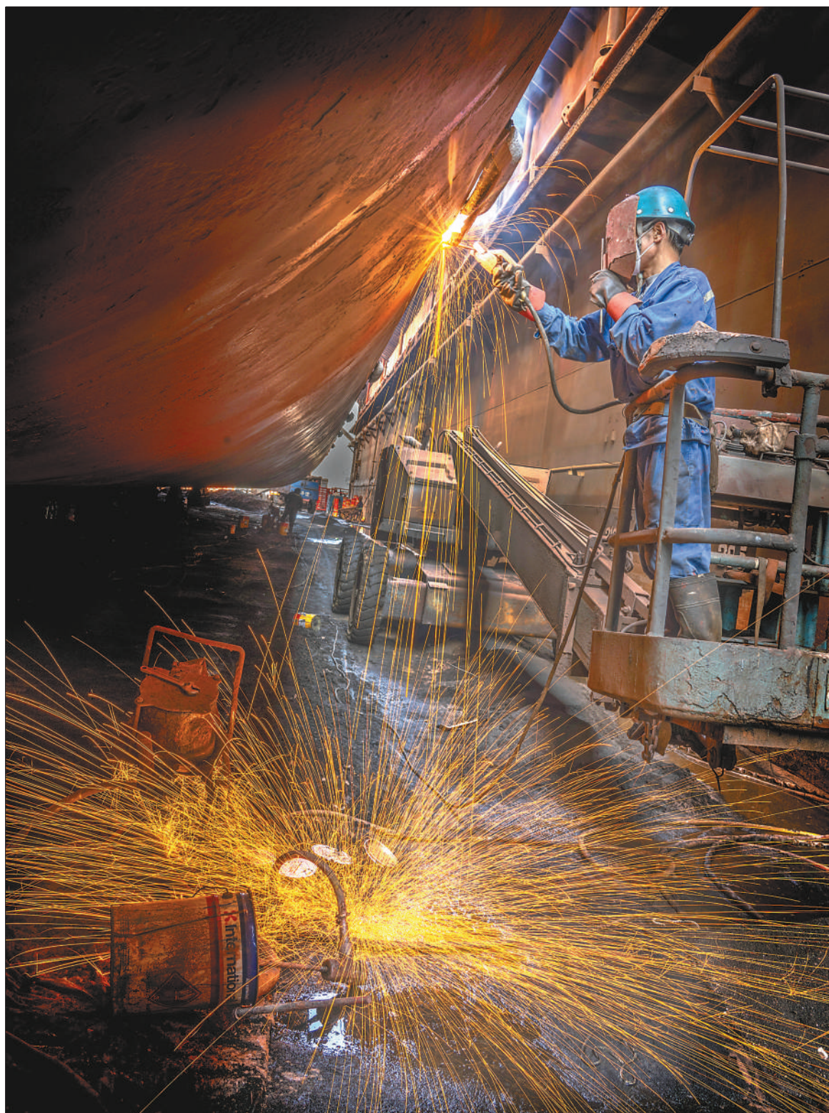
“五一”假期，全国各地不少劳动者仍然坚守生产一线，在岗位上度过劳动节。图为广东中远海运重工船坞内，工人正在进行船体烧焊作业。
