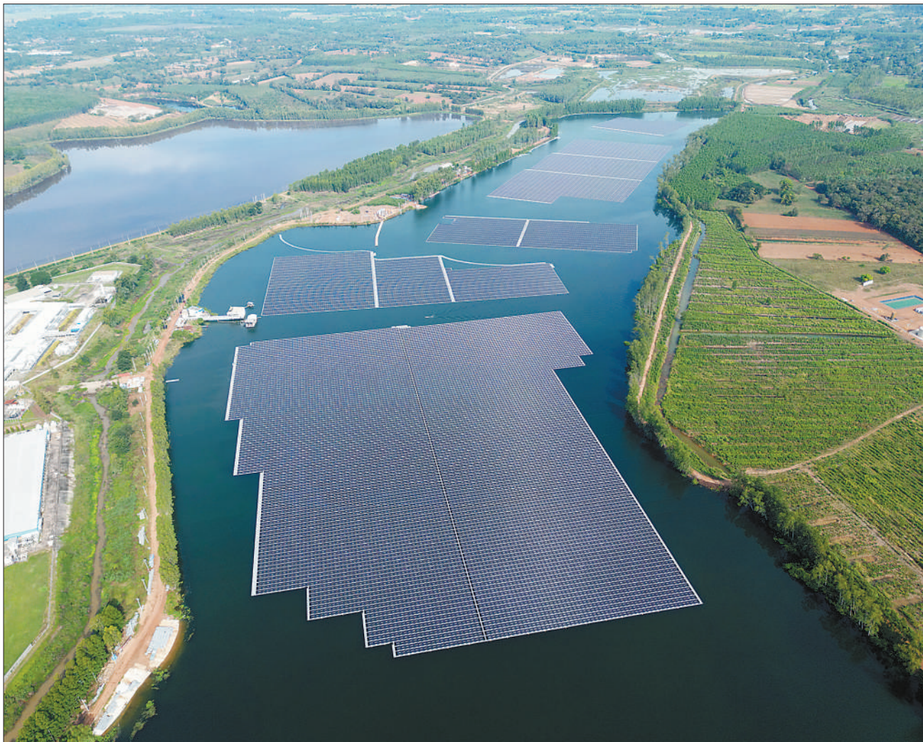
日前,中国能源建设集团有限公司承建的泰国NPS绿湖2x30兆瓦水上漂浮光伏项目全容量并网成功。该项目位于泰国巴真府304工业园区,占地面积约30万平方米,是泰国目前最大水上漂浮光伏发电项目。该项目年发电量可达9500万千瓦时,每年可减少75万吨二氧化碳排放量,将有效推动当地绿色经济和新能源发展,为降碳减排作出贡献。
