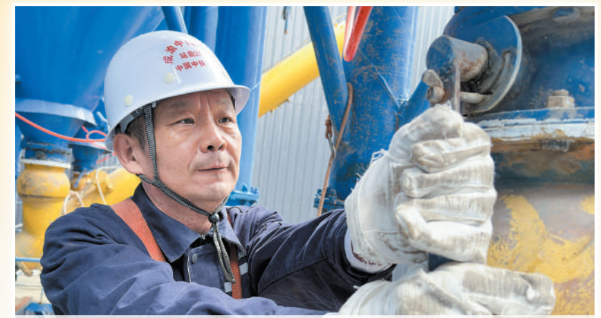
铁路工匠 裴维勇 先后参与京九、武广等25项国家重点铁路工程建设的全国劳动模范、中铁四局二公司机械分公司项目队长裴维勇在成渝中线铁路重庆段站前2标混凝土搅拌站进行主机检修工作。 丁秀赫摄(人民视觉)
