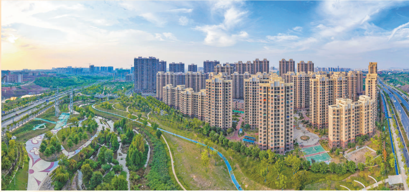
江西赣州市蓉江新区阳光和谐家园保障性住房小区周边,学校、商超、公园等基础配套设施齐全,展现美丽家园新气象。
