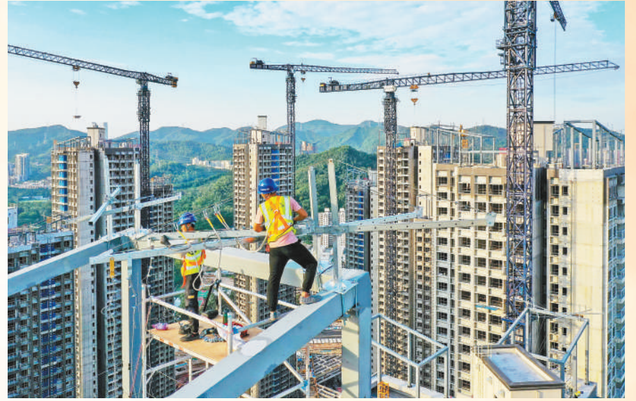
工人在广东深圳市福田区华富村棚改回迁安置房楼顶进行幕墙装配作业。
