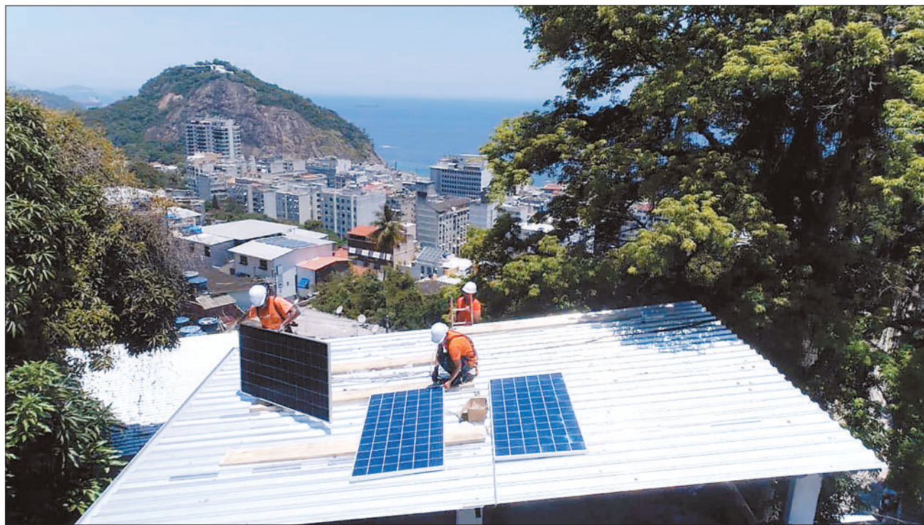
在巴西里约热内卢市一处居民楼,技术人员正在楼顶安装太阳能光伏板。
