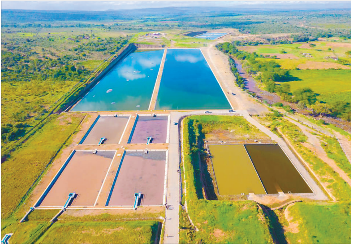
中企承建的肯尼亚纳罗克污水处理厂是当地第一个投入使用的污水处理系统，解决了数千户居民生活用水和污水处理难题。图为纳罗克污水处理厂。
