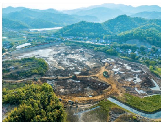
左图：安徽省芜湖市繁昌区繁阳镇范家村，施工人员在铁门水库实施清淤整治作业。肖本祥摄(人民视觉)
