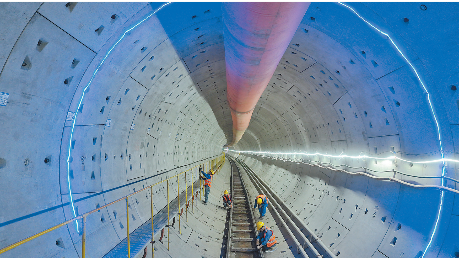
4月22日,浙江省湖州市德清县武康街道,杭德市域铁路隧道工程建设现场,工人在隧道内施工作业。杭德市域铁路全长25.6公里,建成后将与杭州地铁10号线同台换乘。届时,从德清出发,可1小时内到达杭州中心城区。谢尚国摄(人民视觉)
