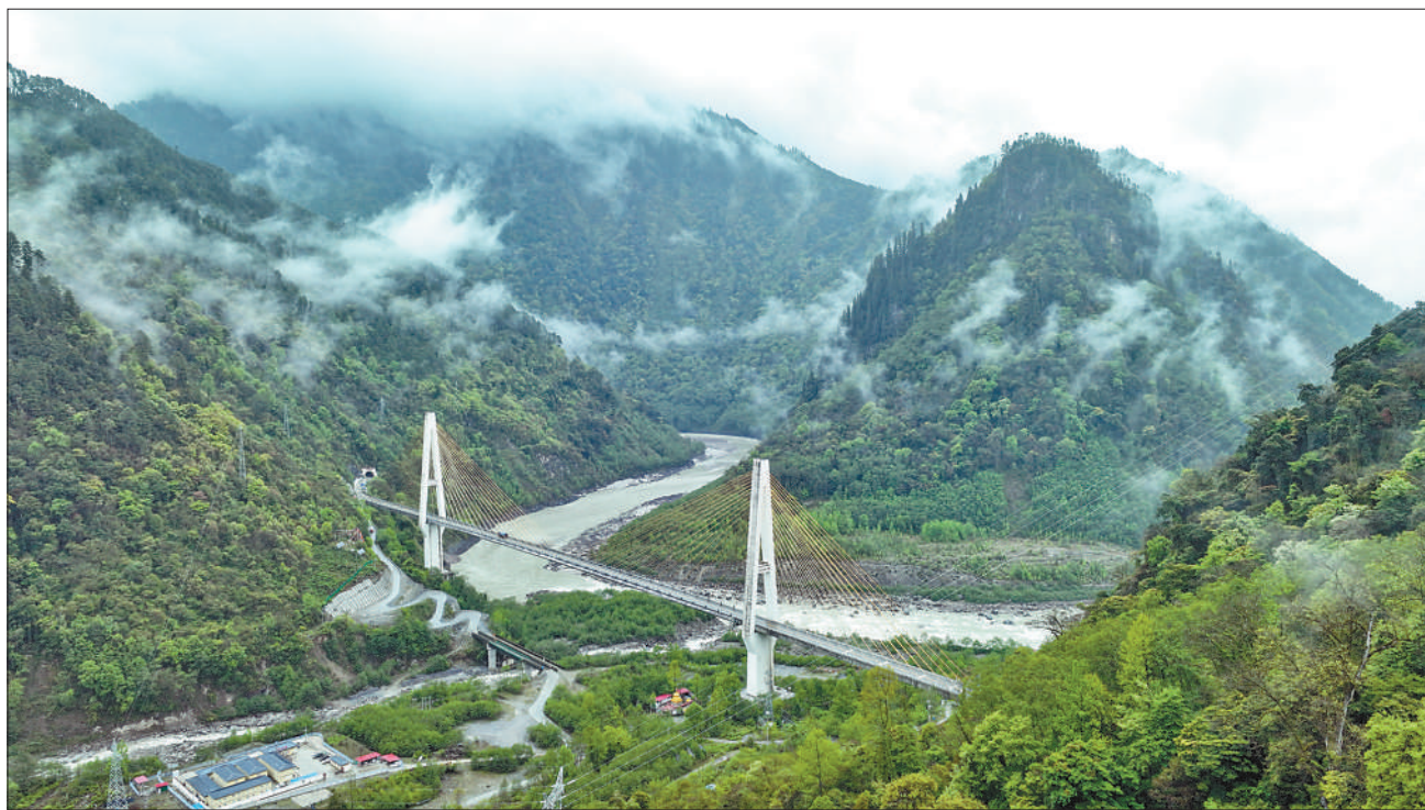
位于林芝市波密县境内的迫龙沟特大桥全长743米,是西藏自治区最大的公路双塔斜拉桥。大桥建成通车以来,有效提升了当地交通运输效率,更好满足了群众的出行需求。
