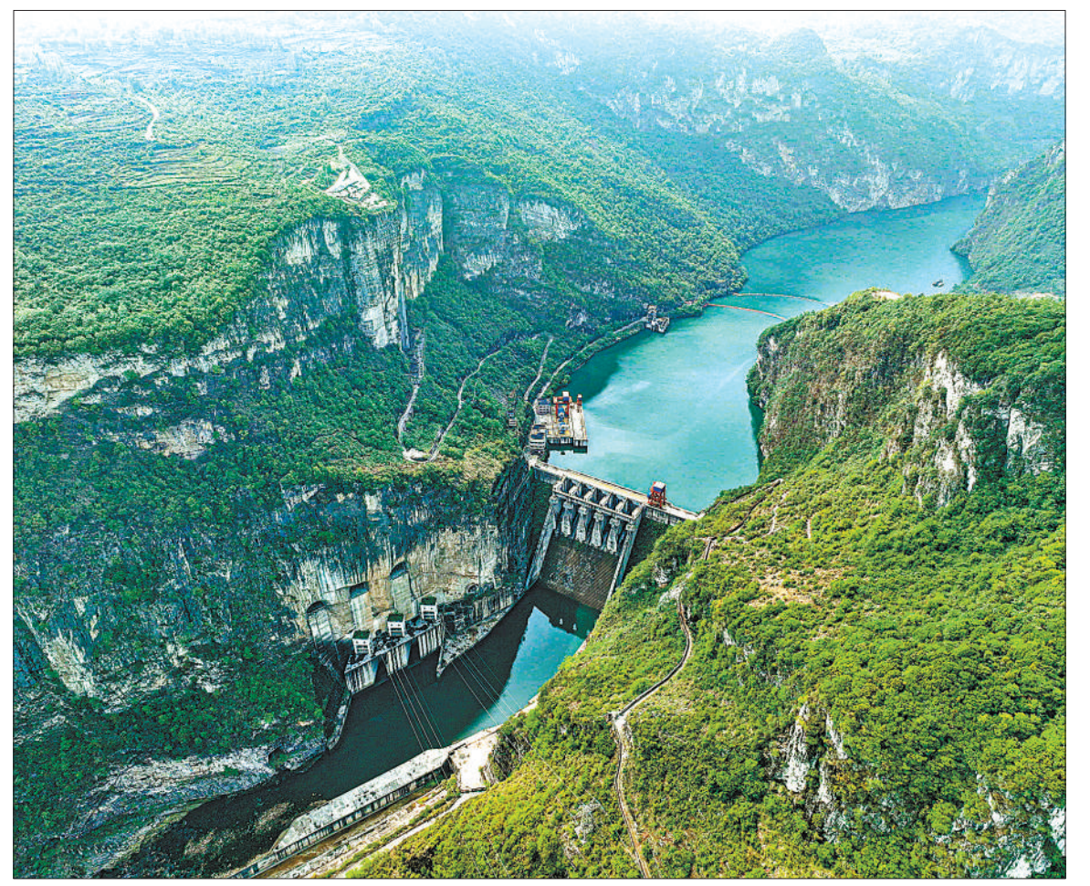
黔西境内的乌江索风营水电站，是贵州省“西电东送”首批开工项目之一，装机容量60万千瓦，水库总库容超2亿立方米，兼具发电、供水、养殖、旅游等多方面功能。图为4月22日拍摄的乌江索风营水电站。
