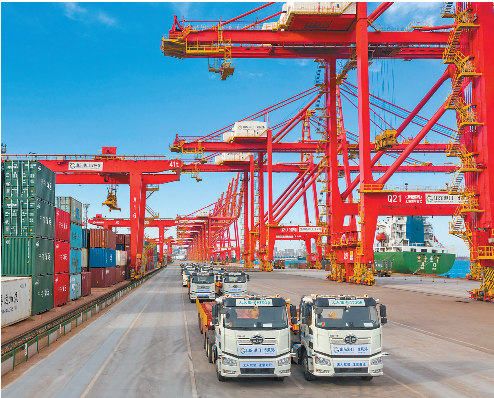
上图:山东港口集团日照港顺岸开放式全自动化集装箱码头,无人驾驶集装箱卡车正在作业。该码头将“5G+北斗”和国产码头操作系统应用到全自动化集装箱作业全过程中,实现了自动化轨道吊“少跑路”、集卡车在堆场“自由行”。
