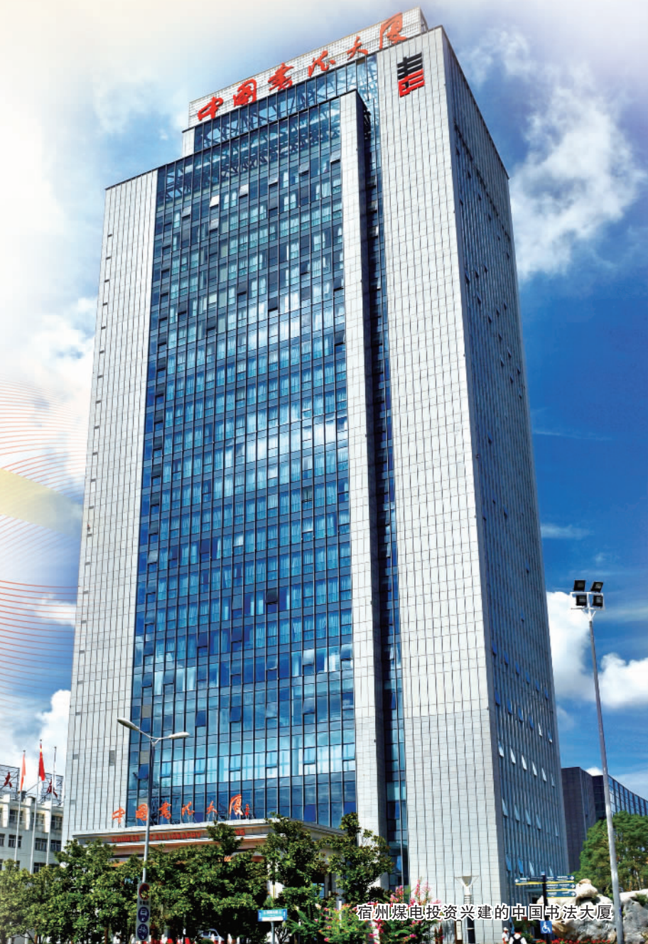
宿州煤电旗杆楼铁矿建设现场
