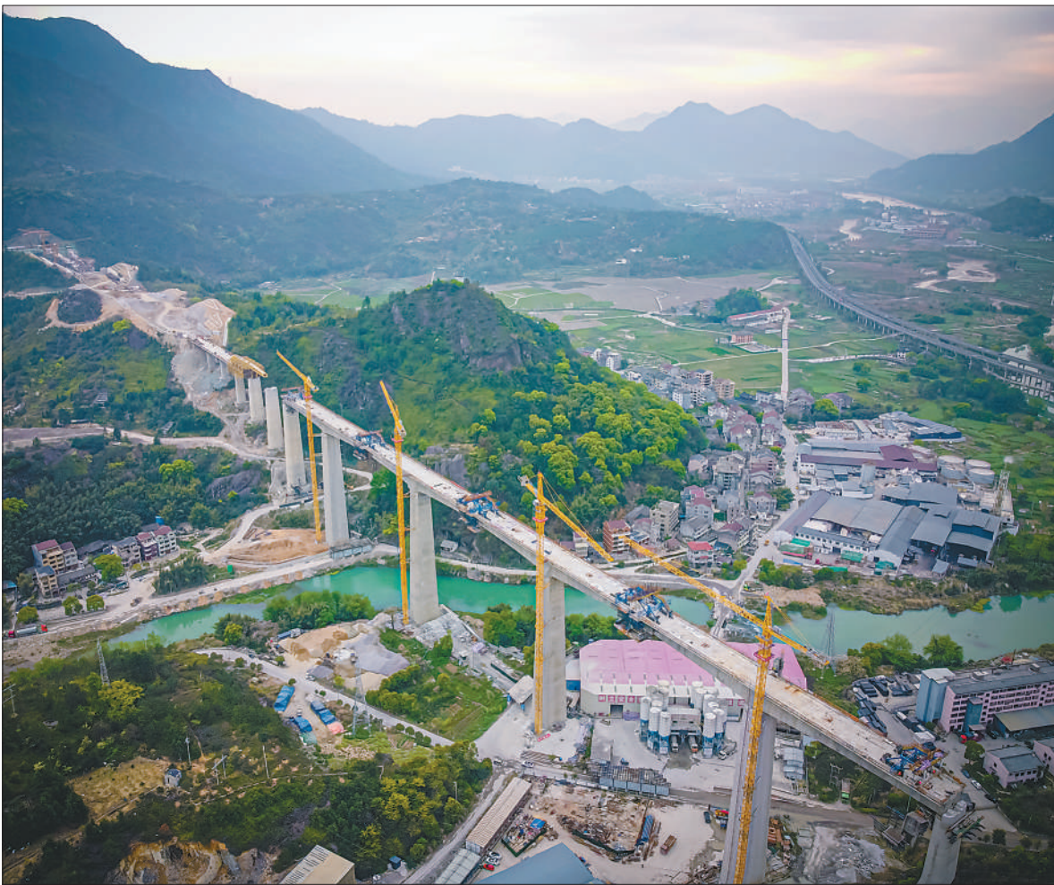
4月1日以来，杭温铁路(杭州至温州高速铁路)控制性工程建设取得重要进展，先后实现了陡门溪特大桥连续梁合龙与麻谷岭隧道全线贯通。杭温铁路设计时速350公里，建成后将增强区域干线高速铁路网，构建浙江省“1小时交通圈”。图为4月3日拍摄的位于温州市永嘉县的杭温铁路陡门溪特大桥施工现场。新华社记者 江 汉摄
