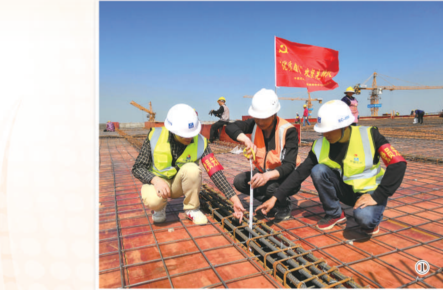
图①:中国建筑五局总承包公司岳阳惠普打印机项目工地上,党员们在测量钢筋保护层厚度。
