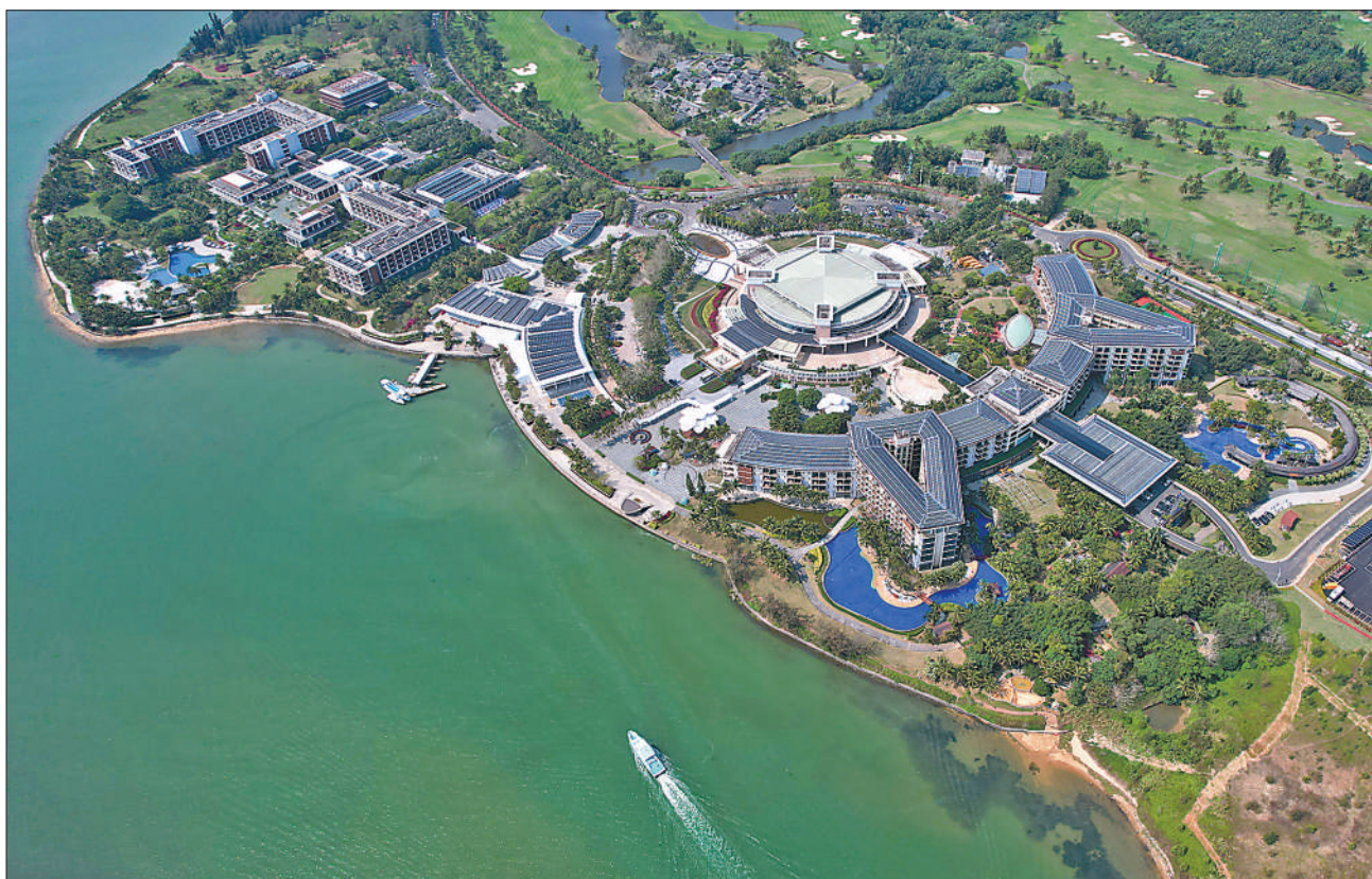
博鳌亚洲论坛2023年年会重点关注绿色发展与能源议题,在新能源生产和规模化应用、新能源汽车、绿色供应链以及储能技术等方面践行“双碳”理念。图为空中俯瞰博鳌零碳示范区,大部分建筑屋顶上都铺设了光伏板。杨冠宇摄(新华社发)
