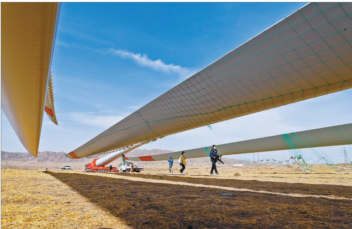
3月27日,甘肃省张掖市山丹县绣花庙49.5兆瓦风电场项目风力发电机组叶片吊装现场,建设者们正在检查叶片。连日来,建设者们紧张忙碌地进行塔筒、主机、叶片吊装和汇集站变压设备的安装调试,着力保障该项目5月底并网。
