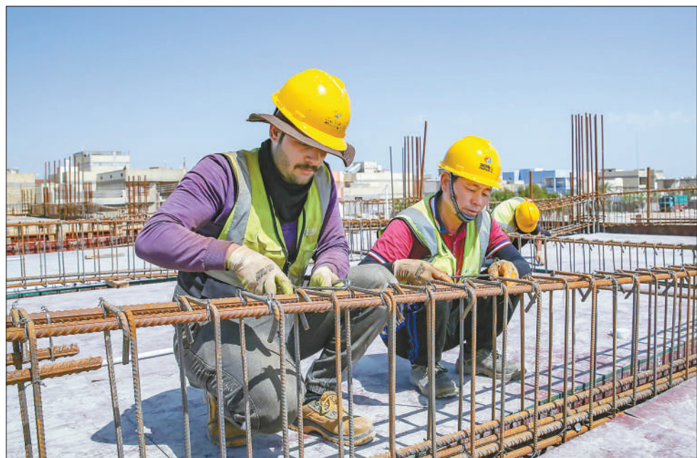
由中企承建的伊拉克示范学校纳杰夫省项目施工现场上，工人在捆扎钢筋。
