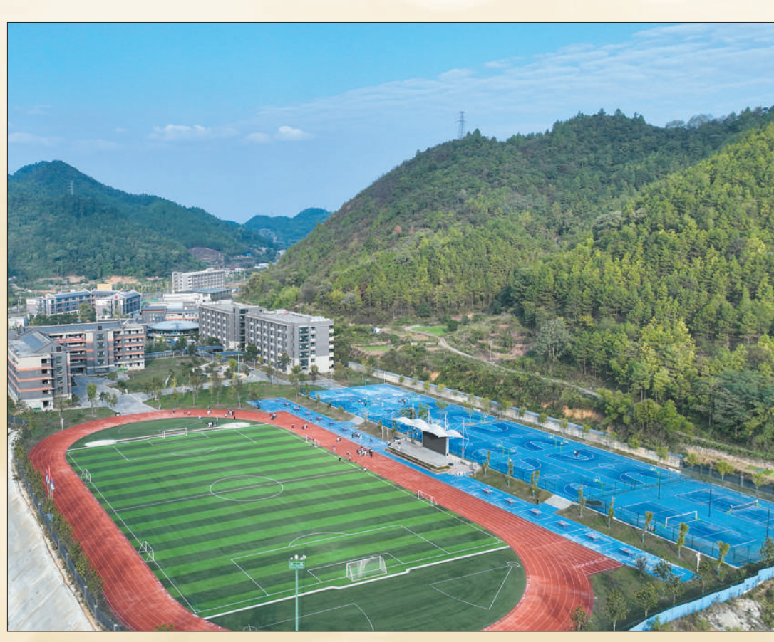
贵州省遵义市一体化教育寄宿制学校天立学校俯瞰。 罗星汉摄(影像中国)
