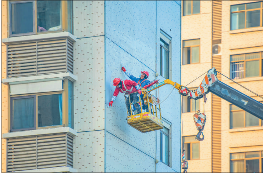
上图:在江苏宿迁宿城区古城街道府前社区,工人正对小区外墙实施修补防水作业。魏琦原摄(影像中国)
