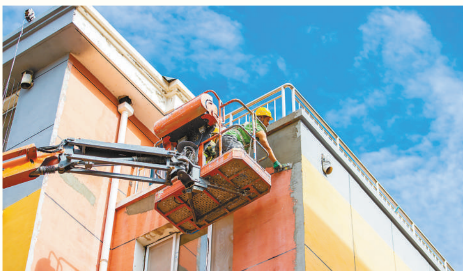
工人在内蒙古自治区呼和浩特市玉泉区石东路街道一老旧小区改造升级现场进行外埠真石漆施工作业。 丁根厚摄(人民视觉)
