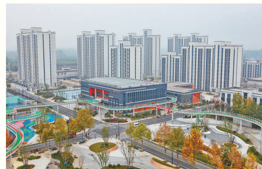
陕西省西安市长安区一处保障性租赁住房项目现场。 文稳翔摄(人民视觉)
