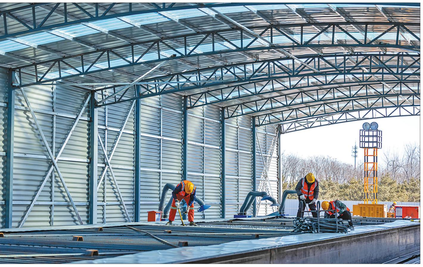
2月25日，京唐城际铁路北京地下段线路开始施工，工人在加工地下连续墙的钢筋笼。据了解，该段线路起自北京城市副中心站地下车站东侧，沿既有京哈铁路南侧，以隧道形式穿通潮路、路县故城遗址、运河减河，上跨城际联络线，线路全长2.4公里。工程建成后，京唐城际铁路自唐山站可直达北京城市副中心站，运行速度提高，运行时间缩短，便利群众出行。
