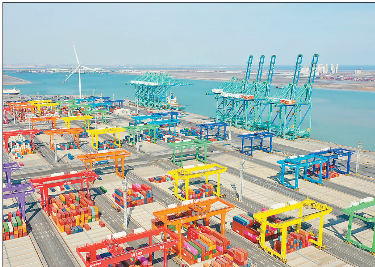
近年来,天津港不断推进智慧港口建设,为京津冀协同发展持续注入新动能。目前,天津港已建成物联网集装箱码头,智能水平运输机器人往来穿梭,码头机械设备自动运转,来自世界各地的集装箱货物在此装卸分拨转运。天津港物联网集装箱码头共安装10万个各类传感器,覆盖生产设备、能源管理、楼宇自控等方面,依托5G全网互联,算力达到传统码头的5倍以上。
