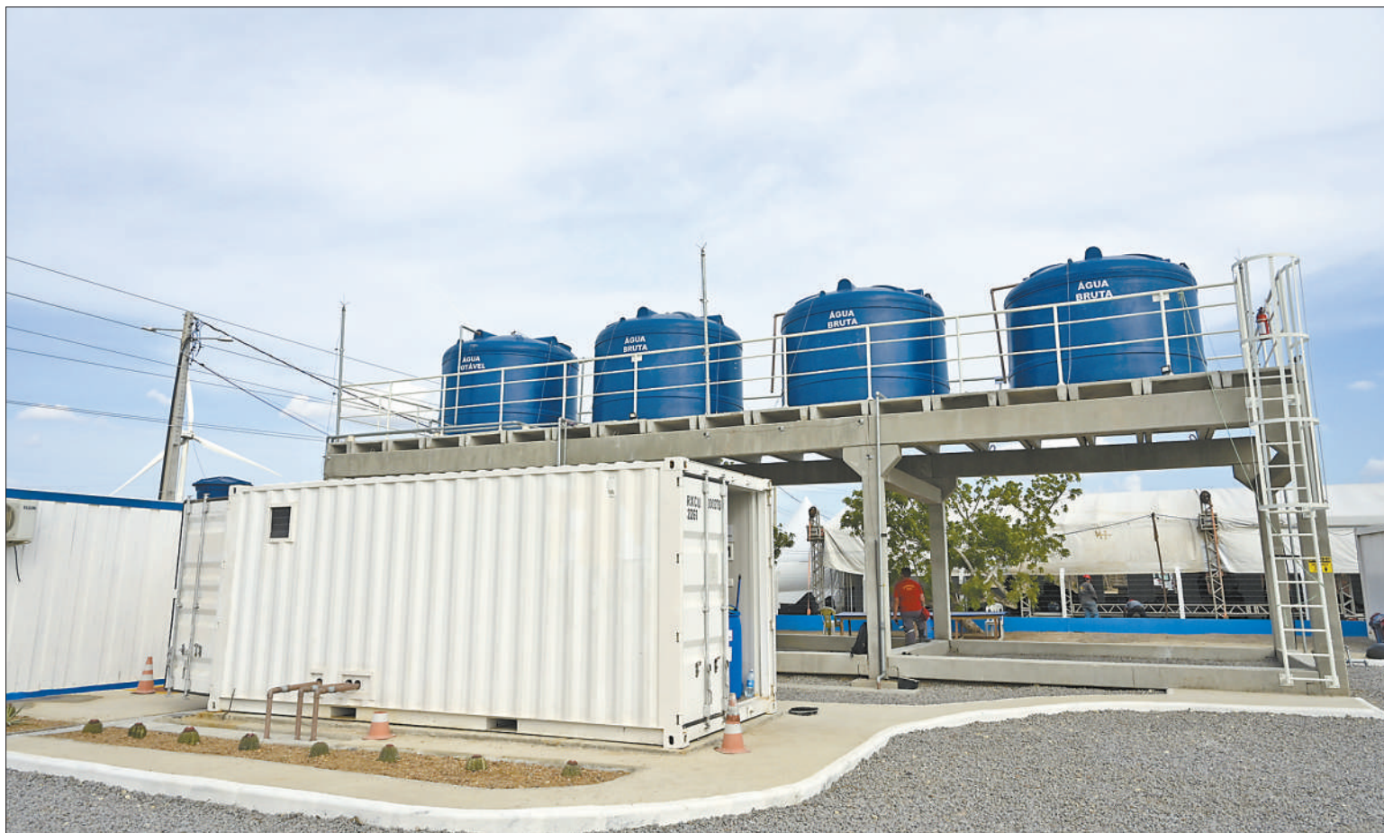
由中国国家电网巴西电力股份公司投资建设的苦咸水淡化公益项目于2月16日正式移交给巴西东北部北里奥格兰德州政府。该项目日均可产80吨纯净水,供该州若昂卡马拉市3个原住民社区居民使用。图为近日拍摄的苦咸水淡化公益项目净化设备。新华社记者 陈昊佳摄
