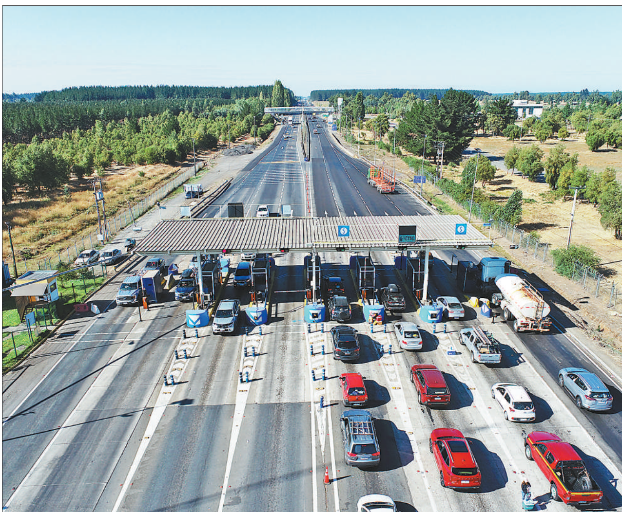
近日,中国铁建国际集团与智利5号公路奇康至科伊普伊段(简称“奇科段”)原特许经营商完成交接,正式启动项目运营。项目内容主要包括升级改造既有线路和新建6.6公里支线,完成后将有效缓解智利南部城市群核心城市交通压力,推动智利南北地区互联互通,并带动沿线相关产业发展。图为智利5号公路奇科段圣克拉拉收费站。
