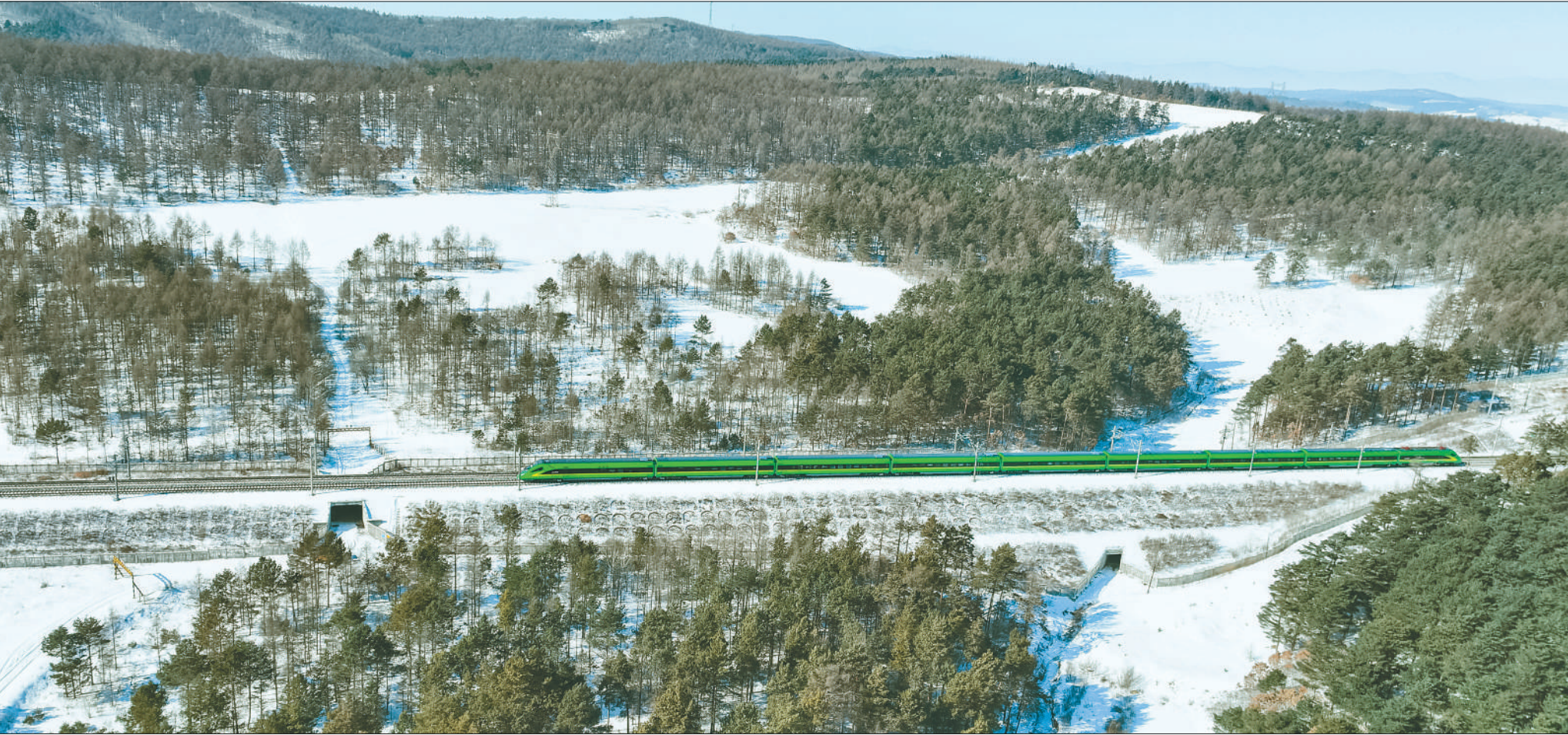
2月15日,哈佳铁路(哈尔滨至佳木斯)沿线银装素裹,景色秀美,“复兴号”动车组行驶在黑龙江大地,成为一道亮丽的风景。目前,黑龙江省高铁营业里程增至1401.13公里,高铁站已覆盖省内大多数区县。
