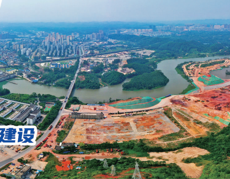
平陆运河钦州先导建设工程2号标段
