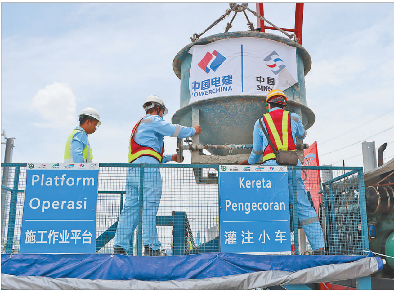
当地时间2月15日上午，随着最后一块无砟轨道板自密实混凝土灌注完工，印尼雅万高铁全线无砟轨道板施工全部完成，为后续铺轨贯通和全线开通创造了有利条件。目前，雅万高铁路基、桥梁、隧道等线下工程已全部完成，站房、四电工程稳步推进，运维筹备工作有序开展。图为无砟轨道板浇筑现场。
