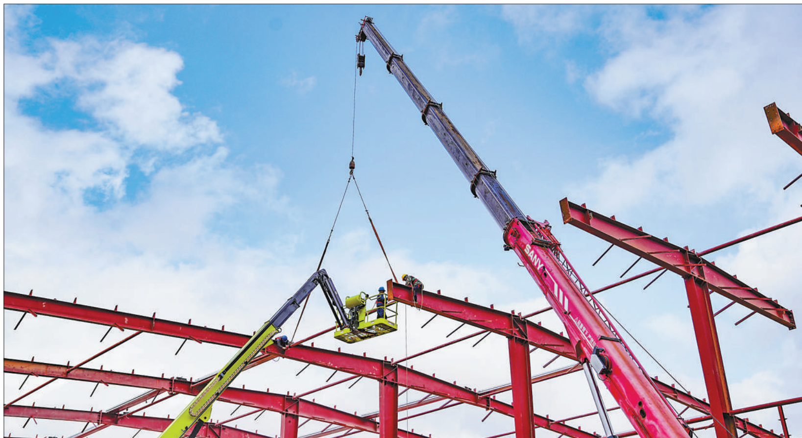
2月12日,位于江西省赣州市定南工业园区的废旧锂电池梯次再生利用项目建设现场,施工人员全力推进项目建设。据了解,该项目总投资20亿元,建成达产达标后,将成为集研发和生产于一体的回收基地,形成完整绿色新能源产业链,推动当地经济高质量发展。 史港泽摄(人民视觉)
