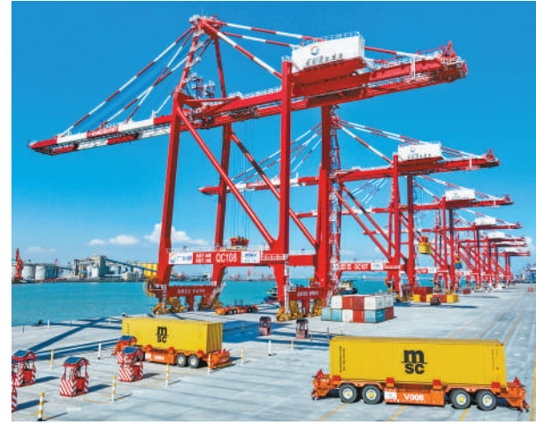
广州南沙港区四期全自动化码头
