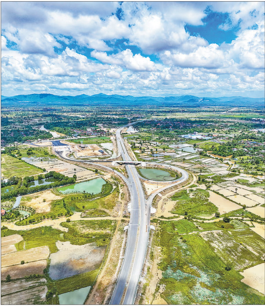
图中企建的金港金港高速公路。
