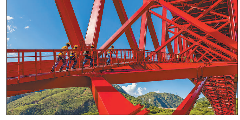
中老铁路元江特大桥检修工检查桥梁设备。
