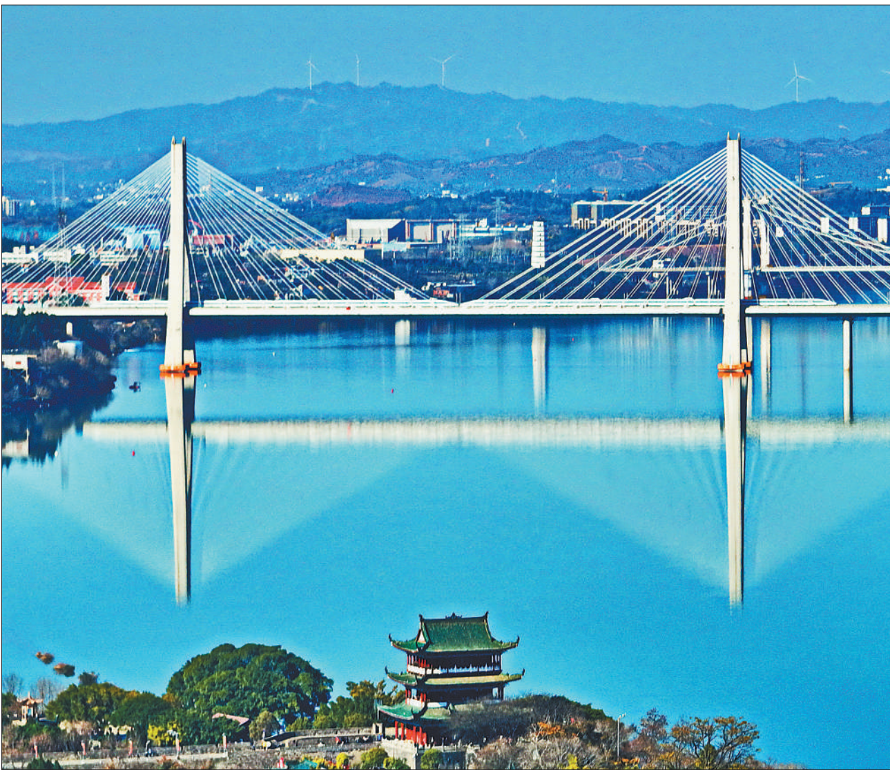
元宵节过后，各大高校陆续开学，学生流、务工流叠加，长、短途客流持续增长，铁路迎来节后首个返程客流高峰，中国铁路南昌局加开旅客列车48趟，方便群众出行。图为2月6日，高铁列车在江西省赣州市的赣江特大桥上飞驰。
