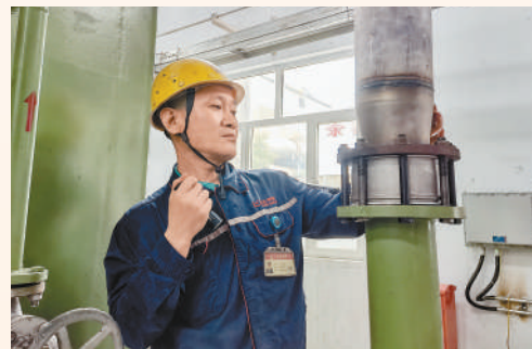
郭彦刚在检查管道焊缝。本报记者 邵玉姿摄
