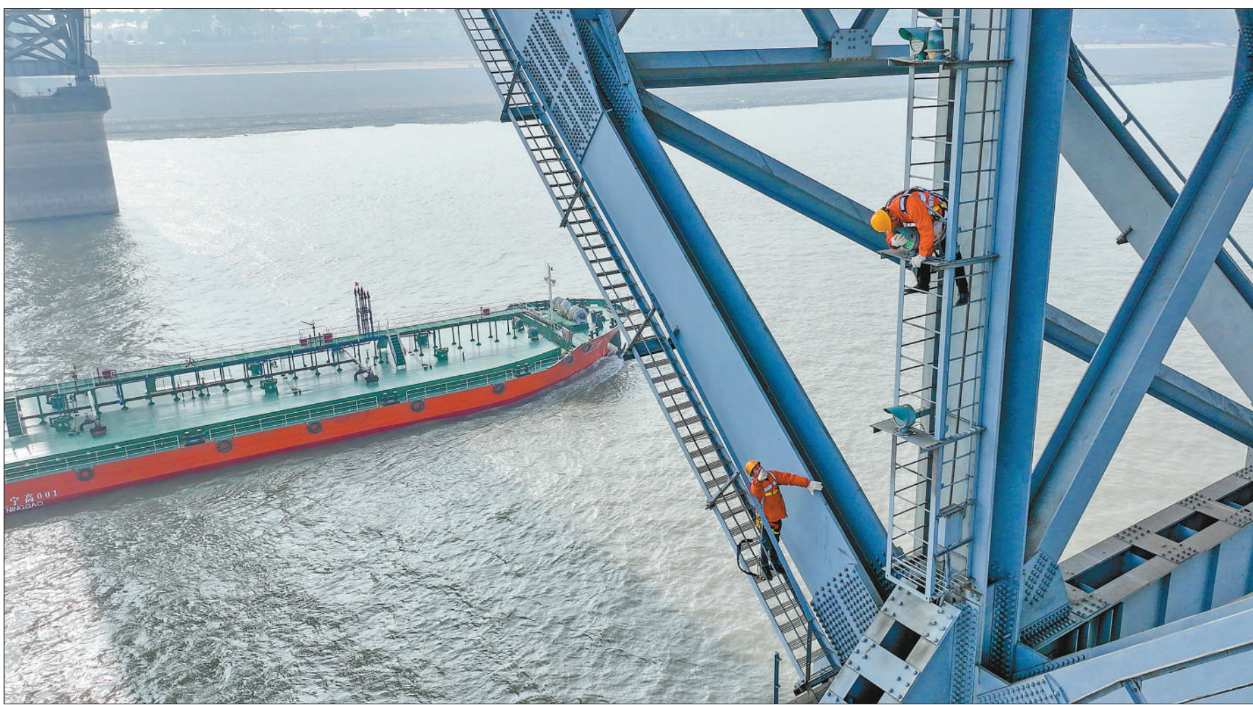
近日，中国铁路南昌局九江桥工段职工正在检修九江长江大桥上的航标灯，为春运安全畅通保驾护航。
