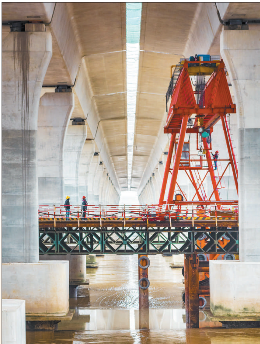
1月11日,中铁十五局建设工人在杭甬复线浙江宁波一期滨海五通立交项目工地上调试龙门吊。该项目为亚洲海上最大互通立交工程,是浙江省公路网骨架“两纵两横十八连三绕三通道”总体布局中的重要一环,预计2023年底建成通车,届时将大大缩短长三角南翼与上海、江苏等地之间的距离。 胡学军摄(影像中国)
