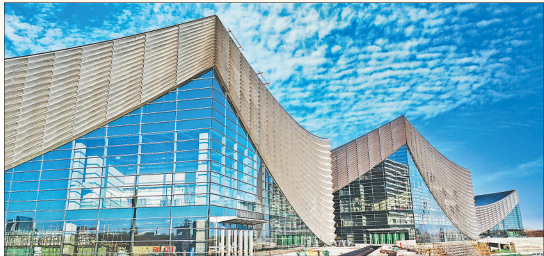
1月15日,建设中的北京城市副中心地标性建筑剧院工程。该项目已进入内部精装修施工阶段,按计划将于2023年底全面完工。 本报记者 贺勇摄
