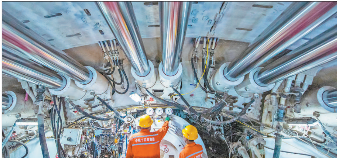
1月14日,安徽省芜湖市城南过江隧道工程左线隧道,中铁十四局工作人员在操作盾构机进行掘进作业。该隧道是目前长江上地质条件最为复杂、施工难度最大的盾构隧道。 肖本祥摄(人民视觉)
