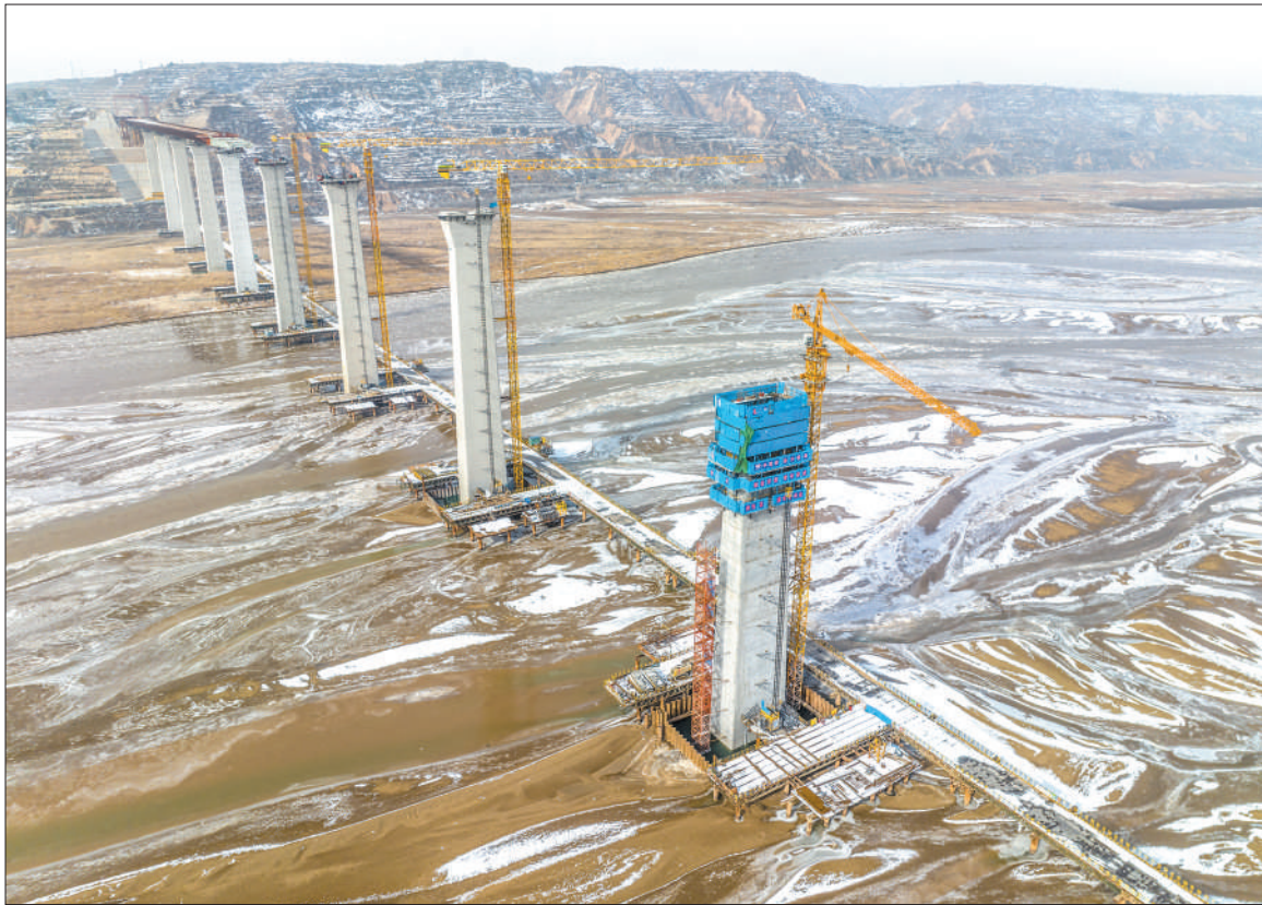
1月17日,山西省运城市临猗黄河大桥项目施工现场。该工程是国家高速公路G3511荷宝线的控制性节点工程,是山西省高速公路网规划“三纵十二横十二环”的重要组成部分。项目全长20.914公里,其中黄河大桥桥梁长5.427公里。 薛俊摄(影像中国)
