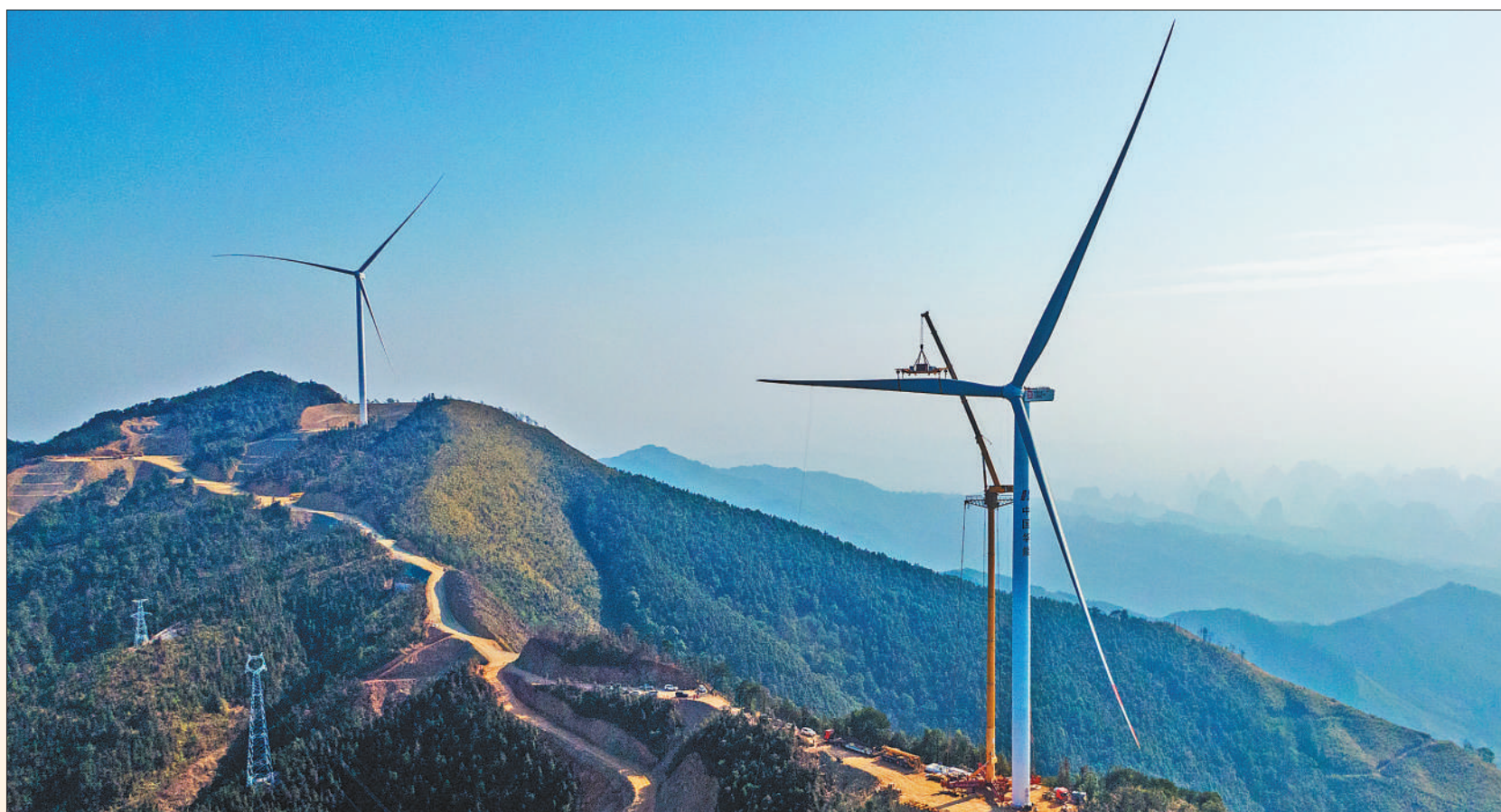
1月10日,广西壮族自治区柳州市融水苗族自治县,华能融水四荣风电场新一组风力发电机正在吊装扇叶,建成后将与已有发电机并网发电。 龙涛摄(影像中国)
