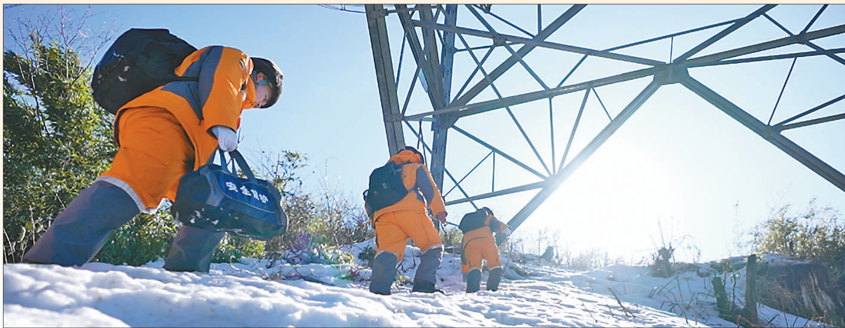
1月13日,四川省凉山彝族自治州雷波县,国家电网四川超高压公司电力工人对锦屏—苏南±800千伏特高压直流输电线路开展覆冰特巡,保障西电东送大动脉可靠运行。 陈兴旺摄(人民视觉)
