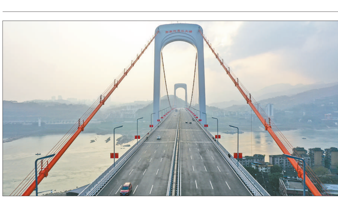
1月18日,重庆郭家沱长江大桥正式通车,助力缓解重庆中心城区路网拥堵。 新华社记者 王全超摄
