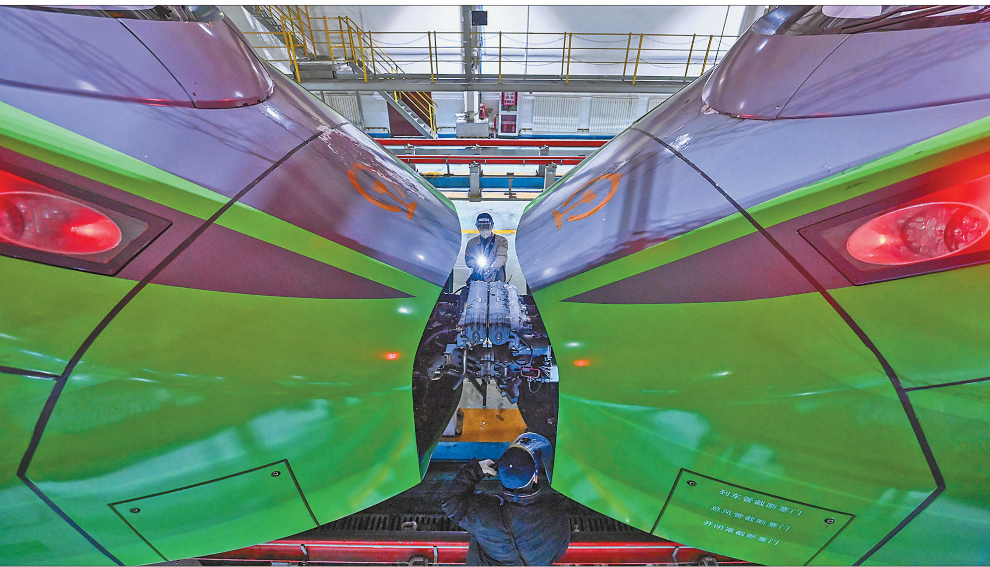
1月14日晚,中国铁路乌鲁木齐局集团有限公司乌鲁木齐车辆段动车组运用所检修库内灯火通明,机械师连夜对动车进行检查、测试、维修工作,保障动车运行安全。
