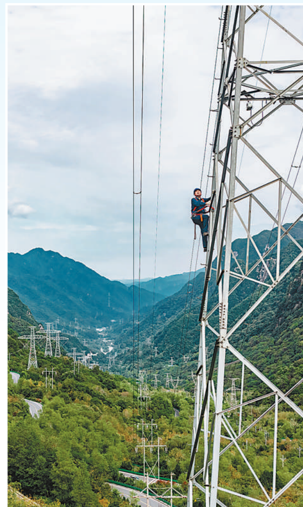
国网陕西宝鸡供电公司工作人员在检修输电线路。 吕文博摄(人民视觉)
