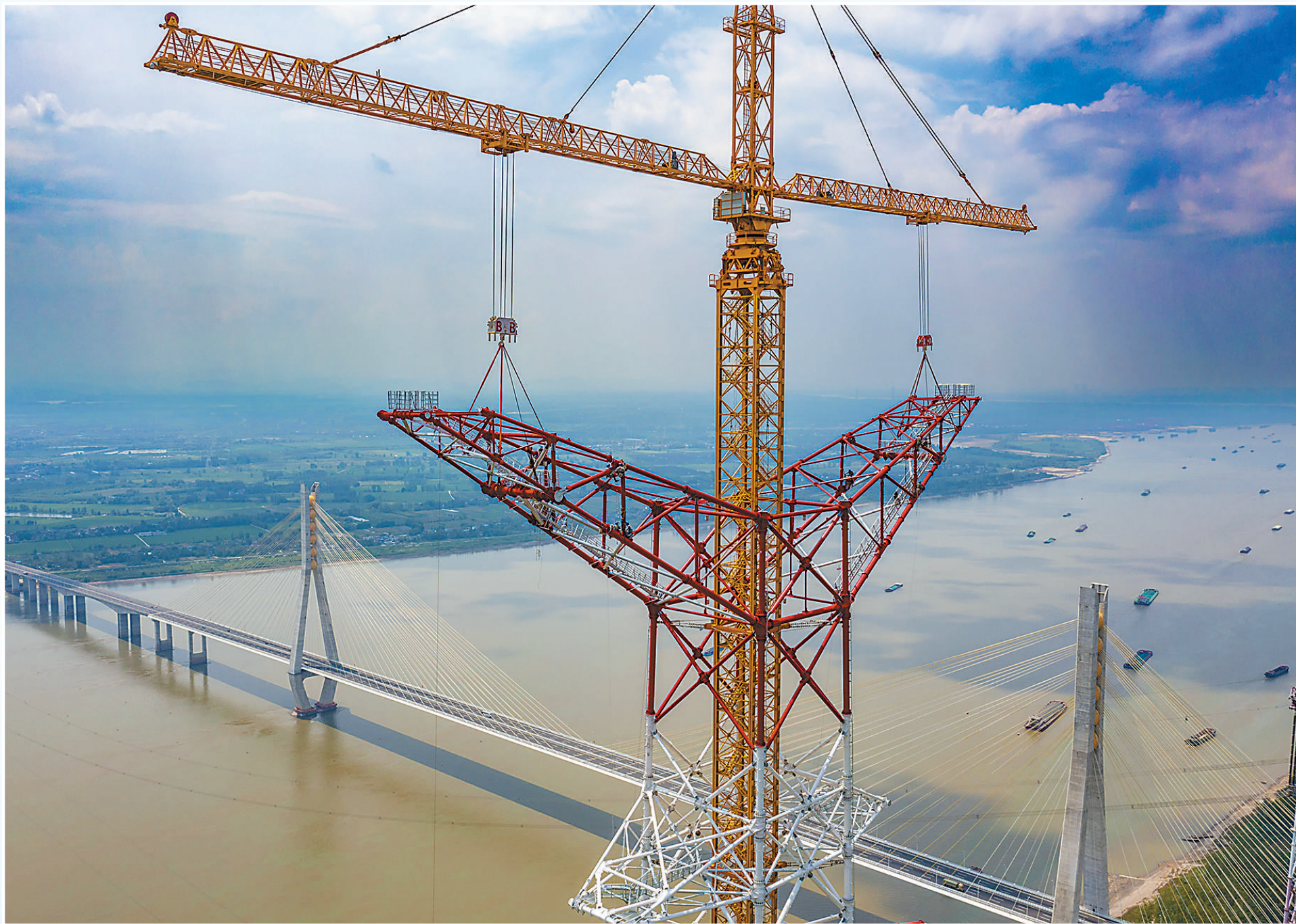
安徽省铜陵市枞阳县长江北岸,白鹤滩至浙江±800千伏特高压直流输电工程长江跨越塔北塔完成封顶,目前该工程已竣工投产。 邵小兵摄(影像中国)
