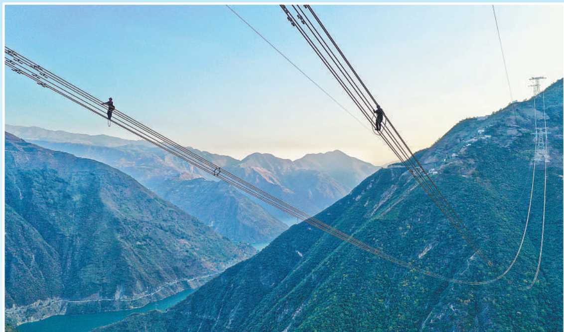
四川省凉山彝族自治州雷波县,国网四川省电力公司超高压分公司电力工人在高空走线验收输电工程线路。 田海摄(人民视觉)
