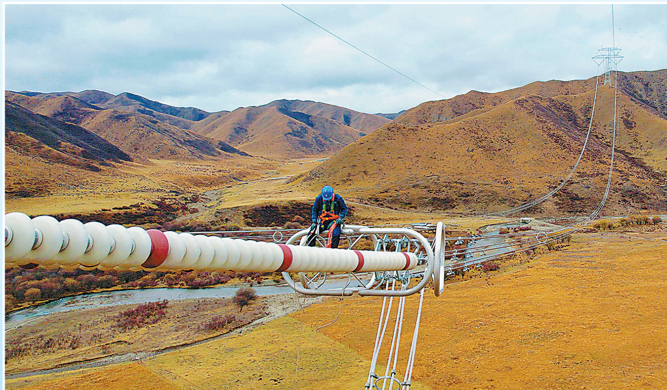
甘肃省甘南藏族自治州夏河县科才镇,国网甘肃省电力公司检修人员在进行±800千伏青豫线缺陷消除作业。 李海峰摄(人民视觉)
