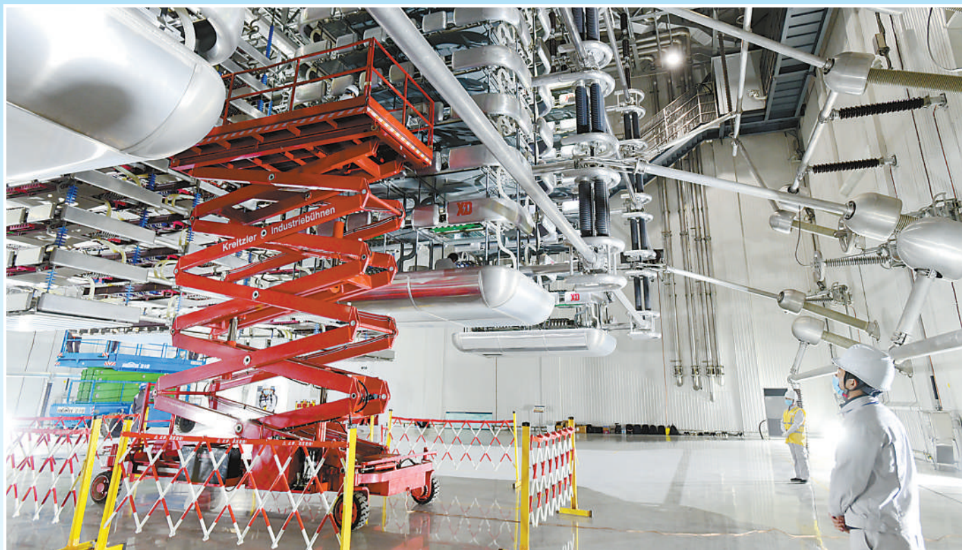
位于黑龙江省的黑河换流站,国网黑龙江超高压公司技术人员在换流阀厅进行检修。 任强摄(人民视觉)
